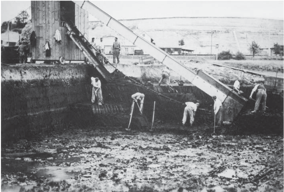
Abb. 11 Torfelevator mit Kettenantrieb im Zweiten Weltkrieg. Die Maschine steht auf Schienen entlang des Torfstichs. Arbeiter stechen am Rand der Grube Torf und schaufeln den Rohstoff zum Elevator hinüber. Die Humusschicht ist hier etwa 60 Zentimeter tief. Im Hintergrund ist das Bahngeleise der Bern-Neuenburg-Bahn sichtbar.
